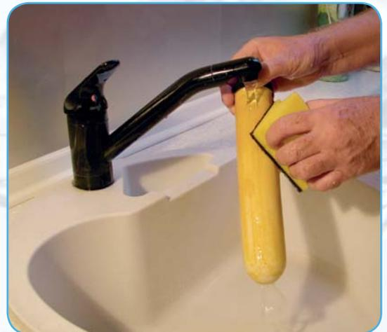
Reinigung des Keramikfilters mit einem Haushaltsschwamm
