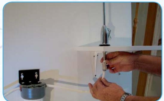
Verbindung zwischen Filter und Trinkwasserhahn
